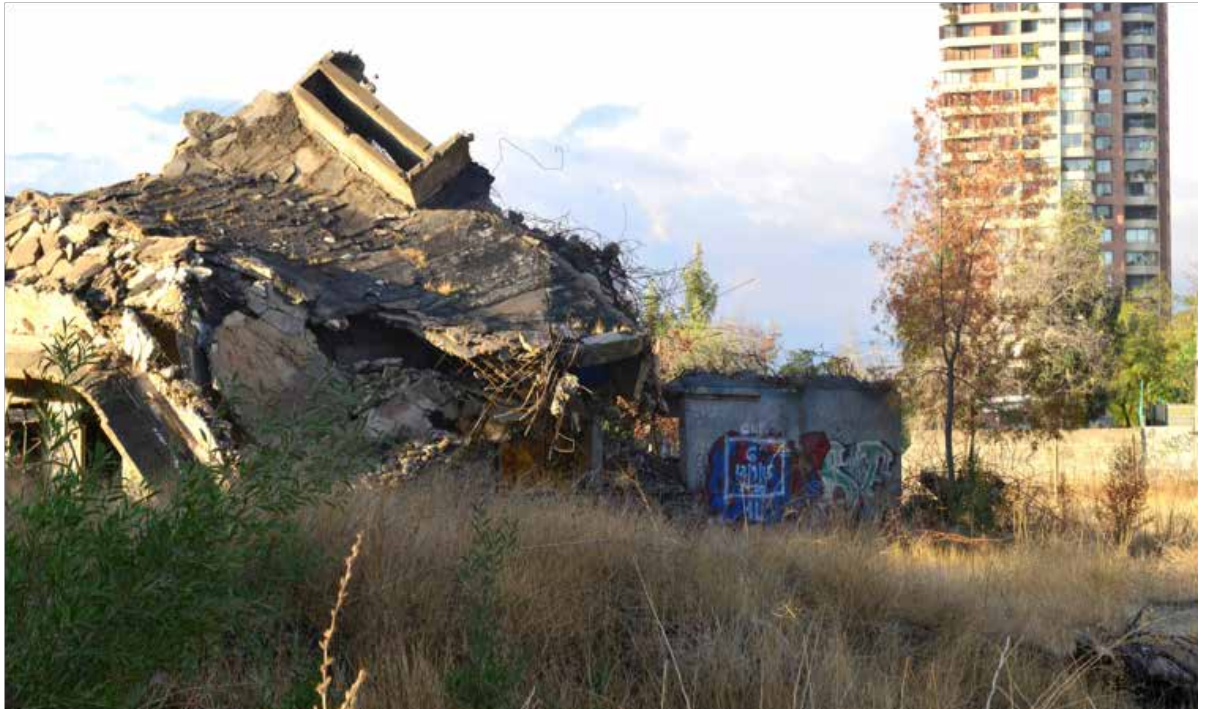
Fig. 4. Block de Villa San Luis derrumbado, 2021. Fotografía de Álvaro Hoppe.
