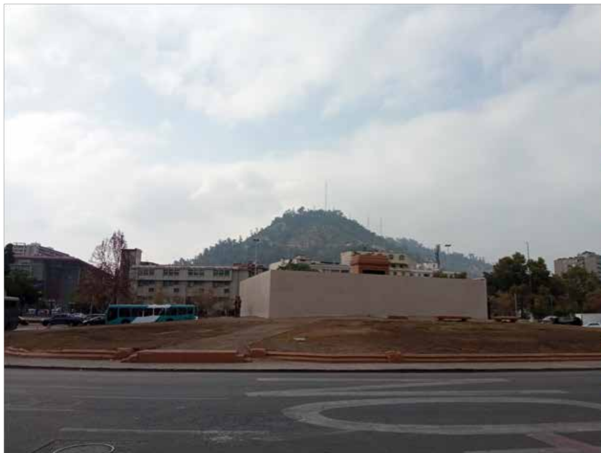
Fig. 1. Vista del muro que protege el plinto de la estatua al General Baquedano, 2021. Fotografía de Oscar Olivares.
